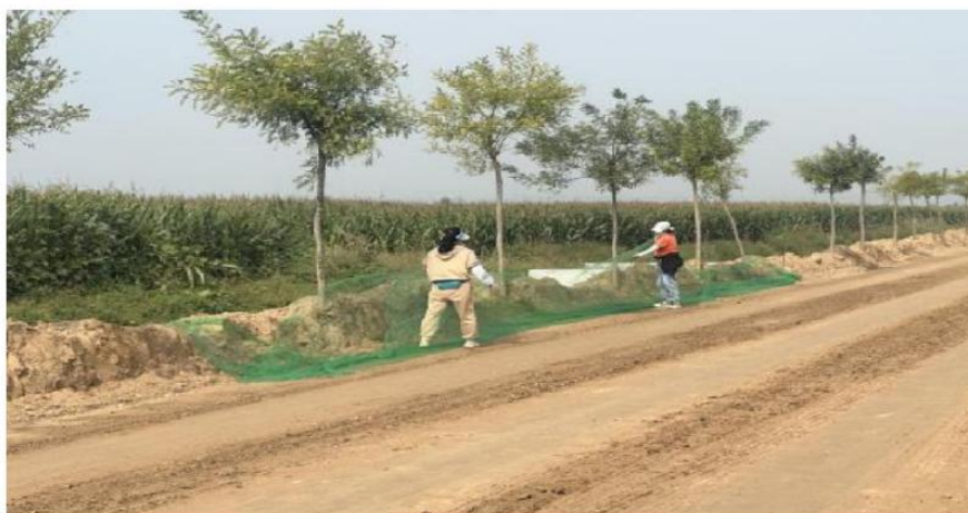
西范工程防汛道路临时苫盖及拦挡措施
