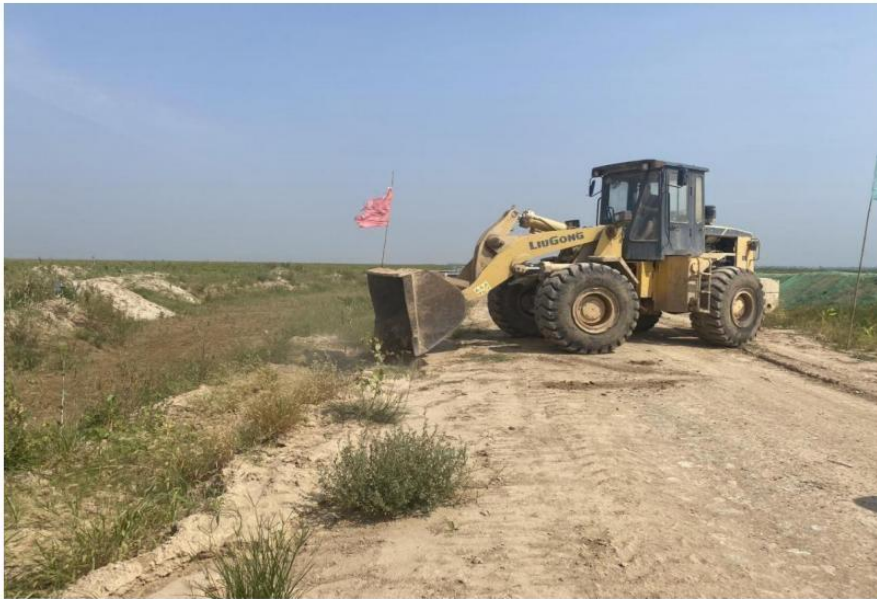
韩家庄上延回淤口冲沟回填
