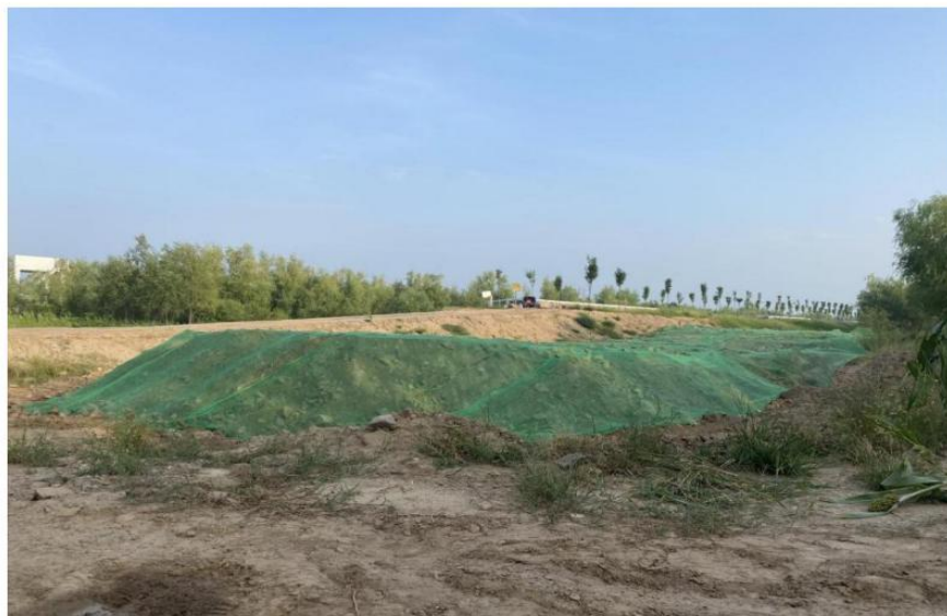
对韩家庄下延 40 号坝弃渣进行了防尘网覆盖
