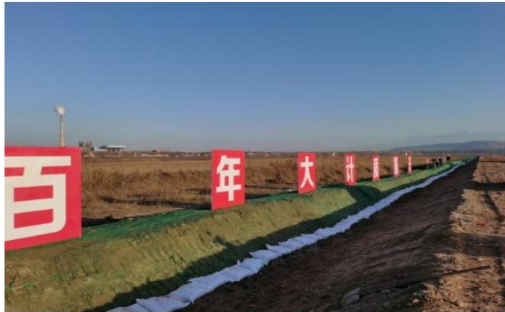
窑河下延工程防治区表土苫盖
