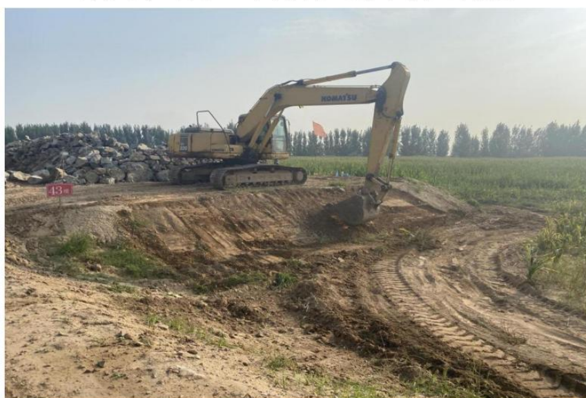
对韩家庄下延备防石台边坡冲沟进行整修
