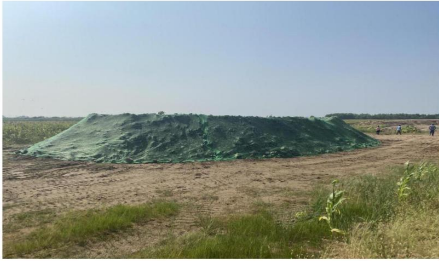
韩家庄上延弃渣防尘网覆盖
