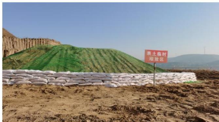
窑河下延工程取土场表土苫盖
