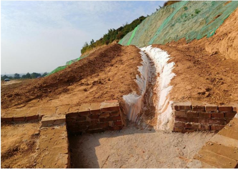
排水沟和集水槽
