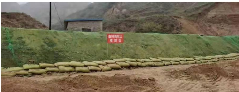
吴王上延工程防治区表土苫盖
