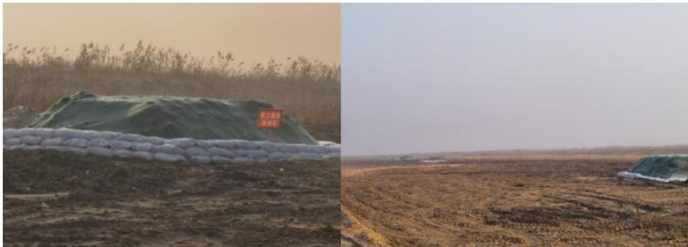
韩家庄上延工程防治区表土苫盖
