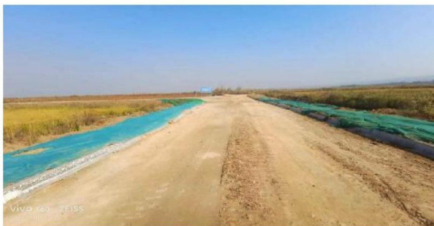
庙前工程防汛道路两侧临时苫盖及拦挡措施
