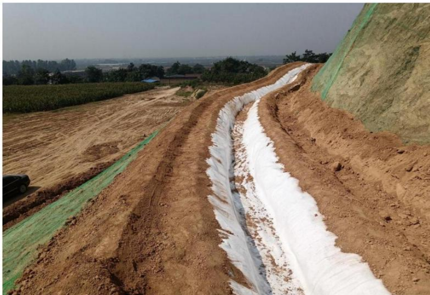
排水沟及临时挡水子埝
