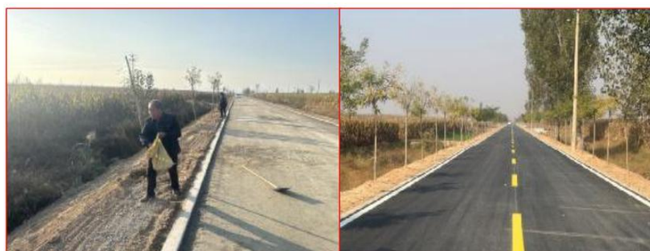
西范工程防汛道路撒播草籽
