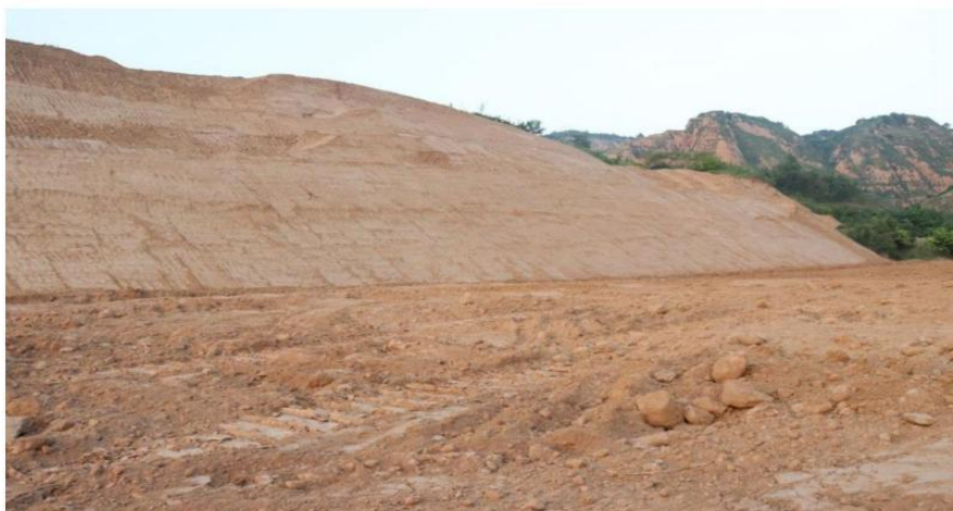
3 级削边坡处理
